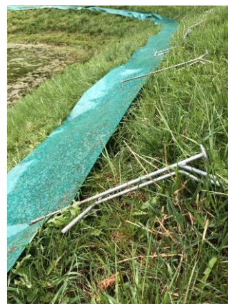
Barrières en attente d'être installées
