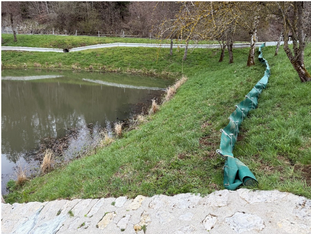
Montage barrières temporaires en complément aux murs en béton
