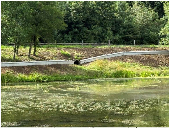
Nouvelles barrières en béton côté sud vers l'étang existant
