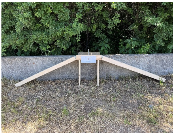
Une passerelle à amphibiens a été installée pour permettre aux batraciens de passer la barrière en béton.
